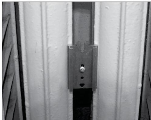
Применяются два типа тепловых адаптеров различной ширины – стандартный (40 мм) и широкий (55 мм).
